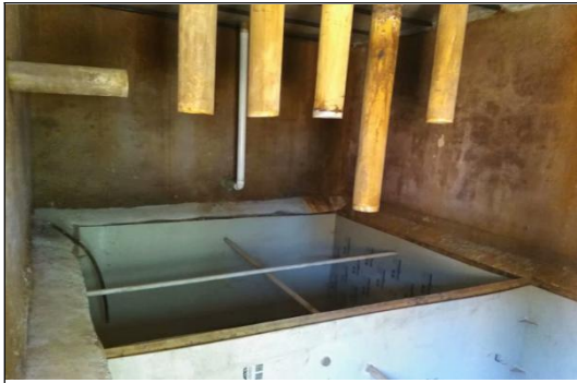
初期雨水收集池
