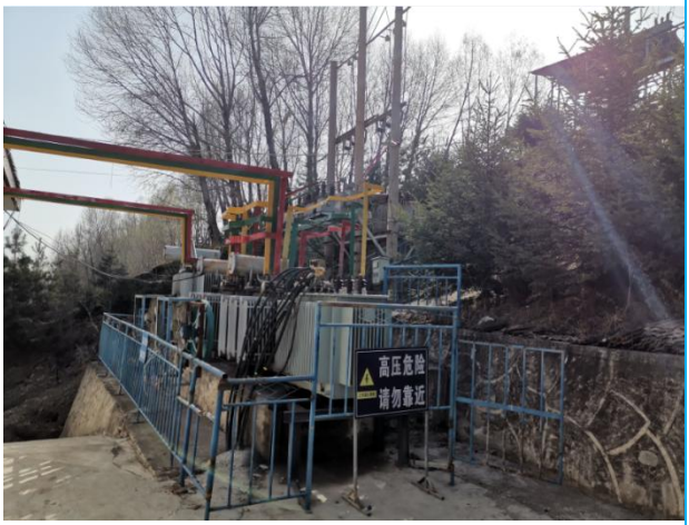
升压站绿化情况
