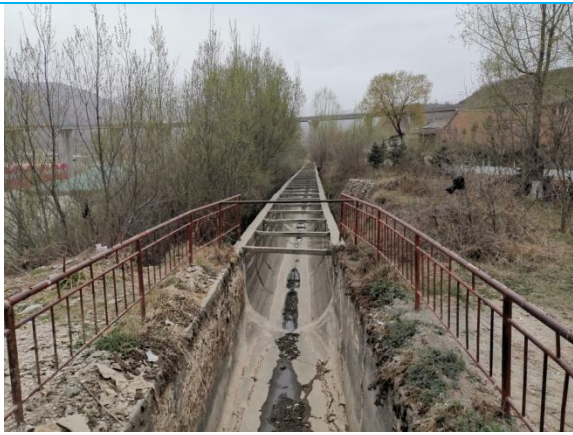
尾水渠绿化情况
