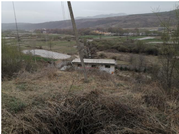
发电厂房绿化情况
