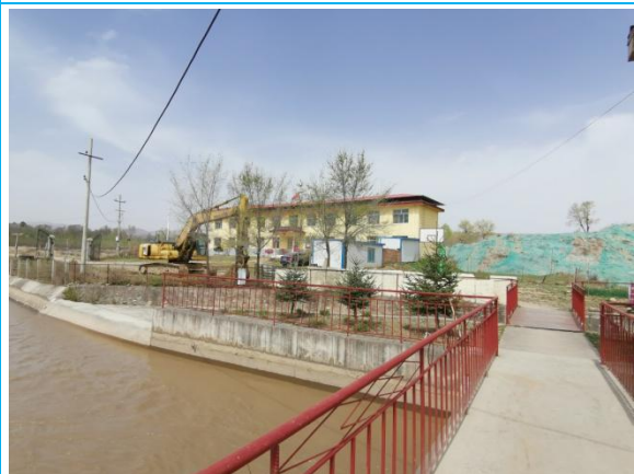
尾水渠绿化情况
