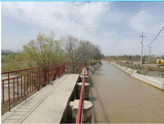
尾水渠绿化情况
