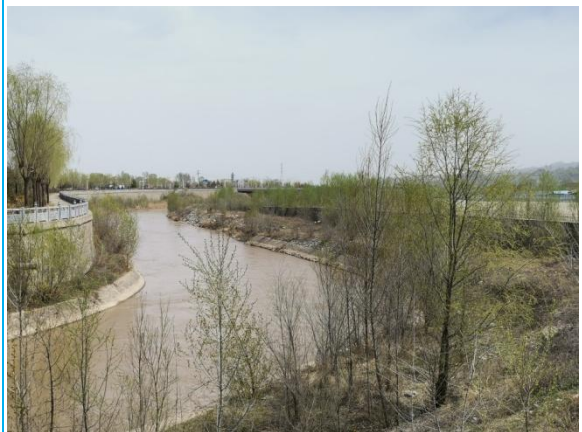
尾水渠绿化情况
