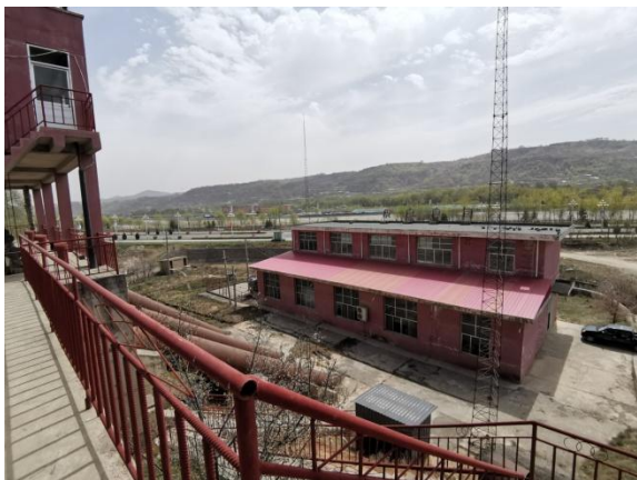
发电厂房绿化情况
