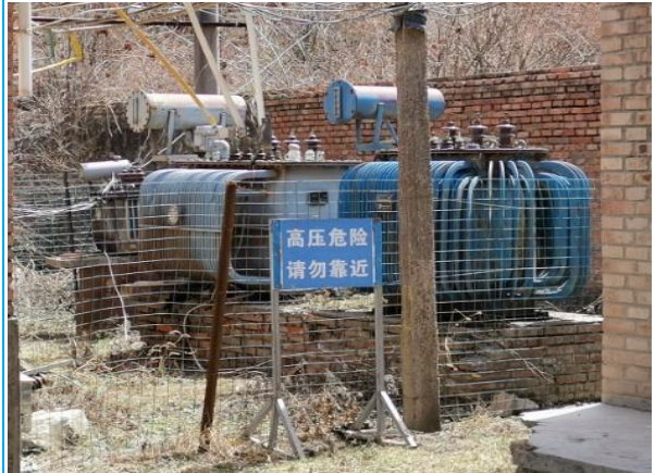
升压站绿化情况
