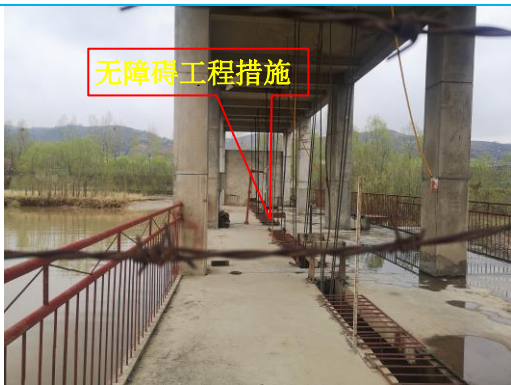
生态下泄流量无障碍工程措施
