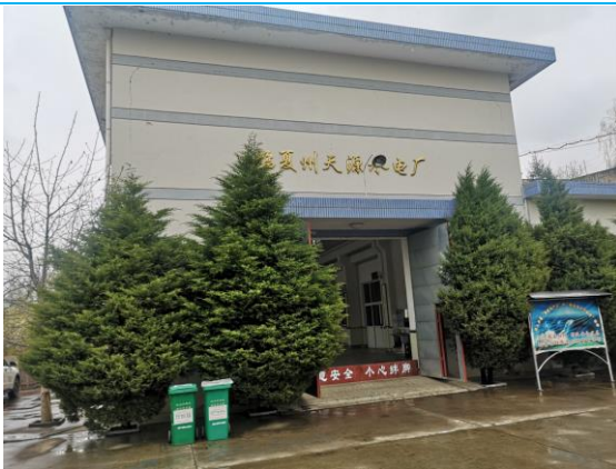
发电厂房绿化情况
