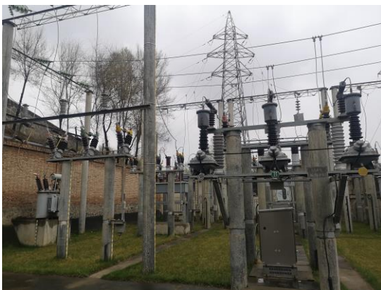
升压站绿化情况
