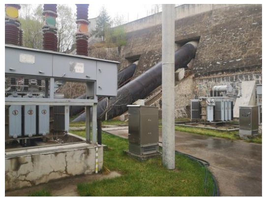
升压站绿化情况
